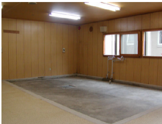
a) 手漉き工房、基礎・水場改修工事 7月中旬、2週間をかけ、紙漉き機器・備品の導入のための基礎、及び水道水と地下水の吸水、排水処理の改修工事を実施した。
